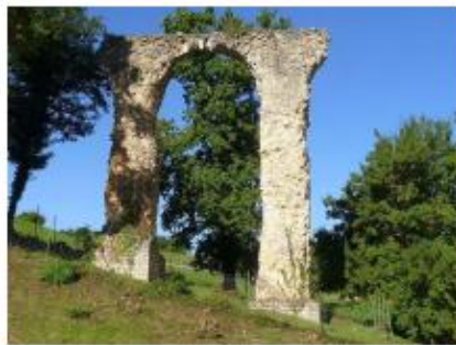
aqueduc de Saintes construit entre 20 et 120 après JC
